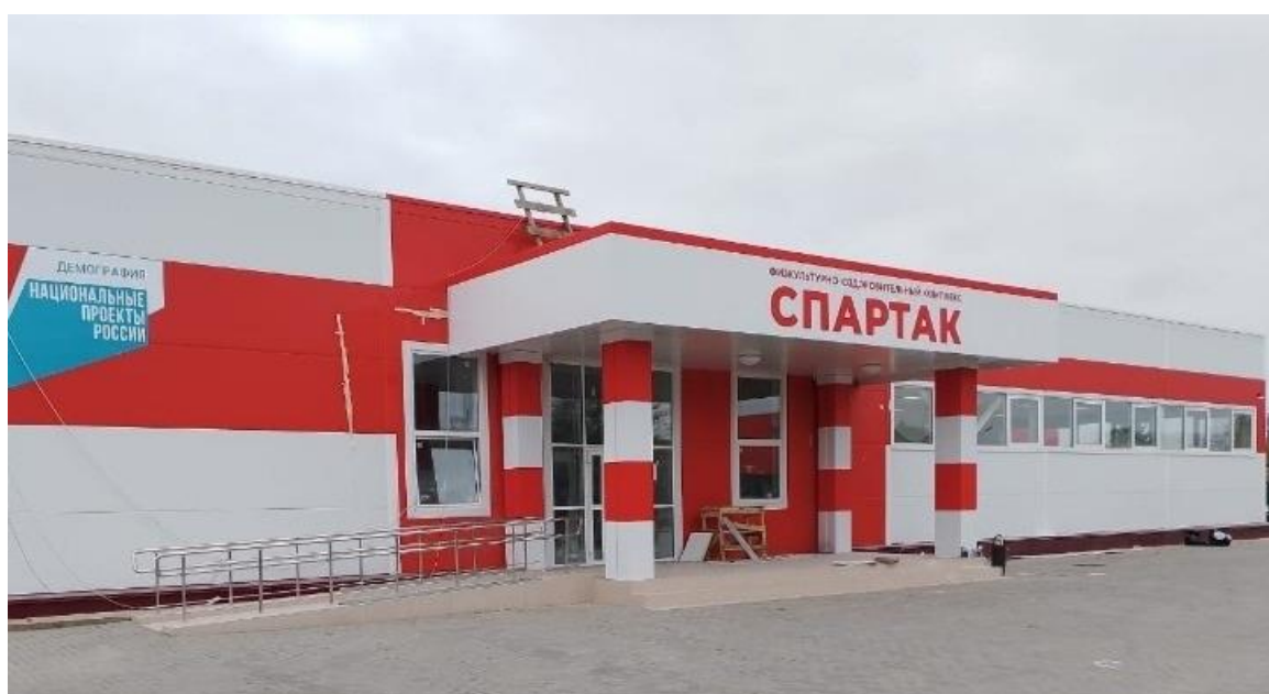
ФОК «Спартак» г. Рассказово (на завершающем этапе строительства)
